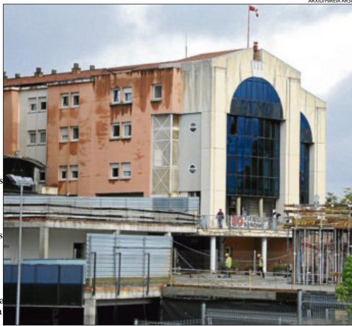
Imatge d'arxiu de les obres d'ampliació de l'Hospital de Sant Joan de Déu
